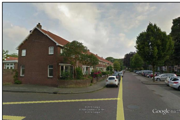
Woonhuizen nrs 25 t/m 149.
